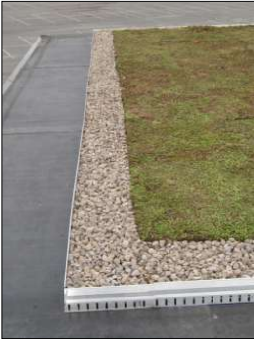
Left: Ballast edge detail
