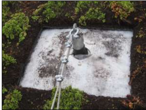
Left: Ballast edge detail
